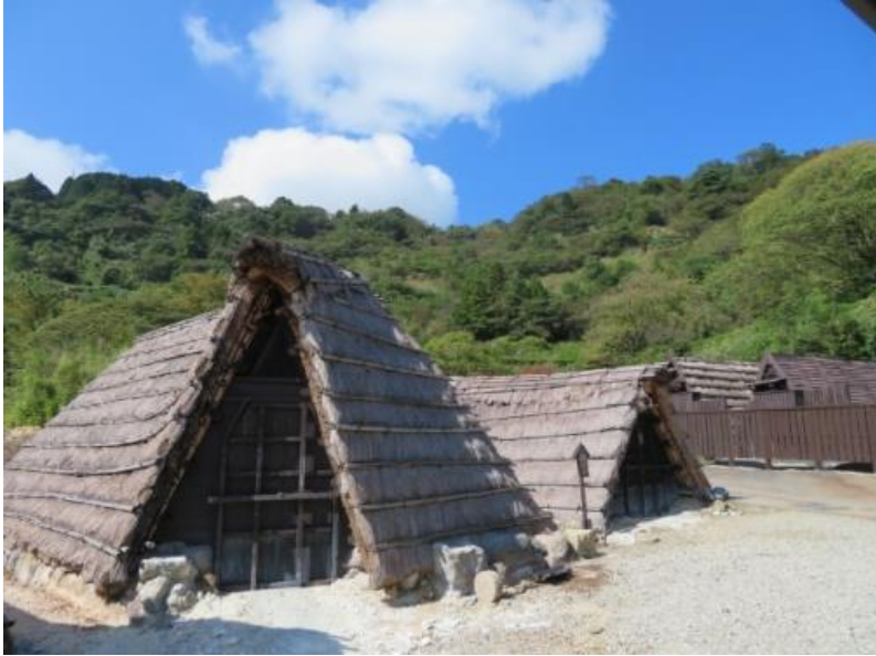
敷地内に点在する湯の花小屋
