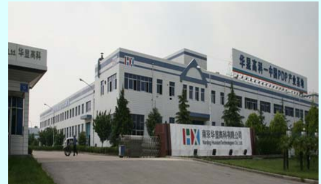
南京华显高科有限公司 Nanjing Huaxian High-tech Co. Ltd
